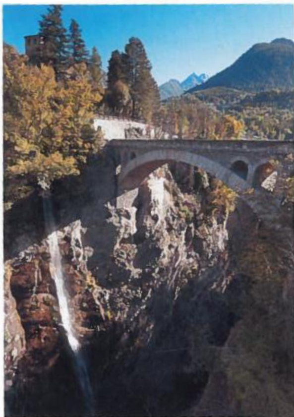
Il ponte sulla Dora di Rhêmes
